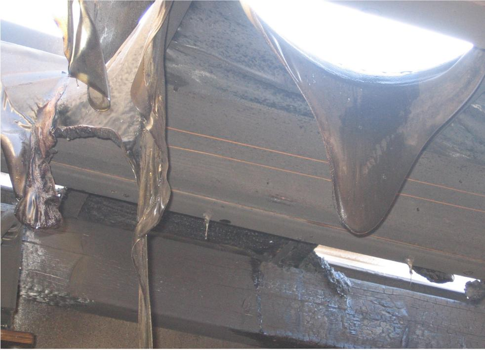
durch Hitzeeinwirkung geschädigte Deckenplatten aus Kunststoff
